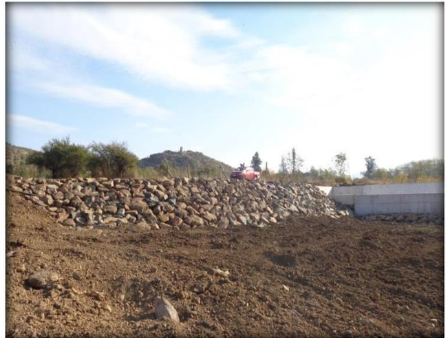
**Enrocado de protección, lado sur de la bocatoma.**
