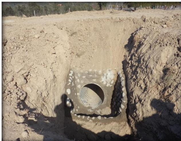
Tubo HDPE para desague aguas lluvias, Km 11,050.
